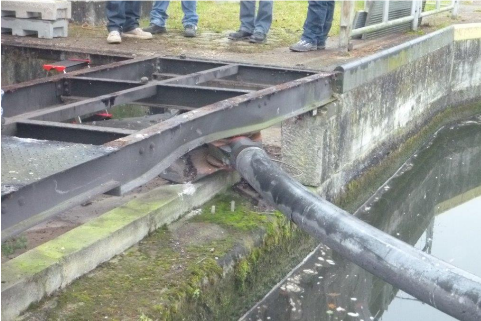
Foto1: verbogene Schubstange am Tor
